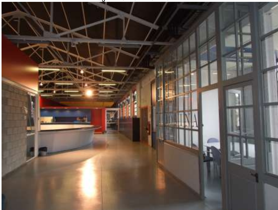
Vista encavallades coberta
